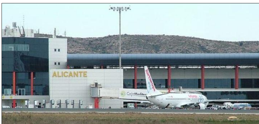
Aeropuerto del Altet
